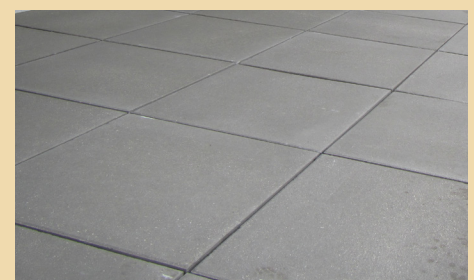
Betonplatten auf der Terrasse/Balkon
