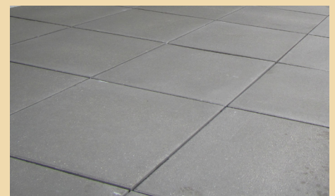
Betonplatten auf Terrasse/Balkon
