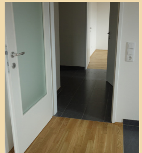
Barrierefreier Übergang der Böden, ohne Schwellen
