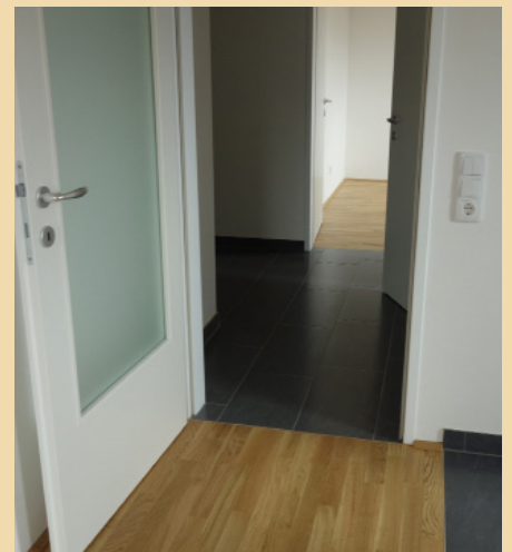
Barrierefreier Übergang der Böden, ohne Schwellen
