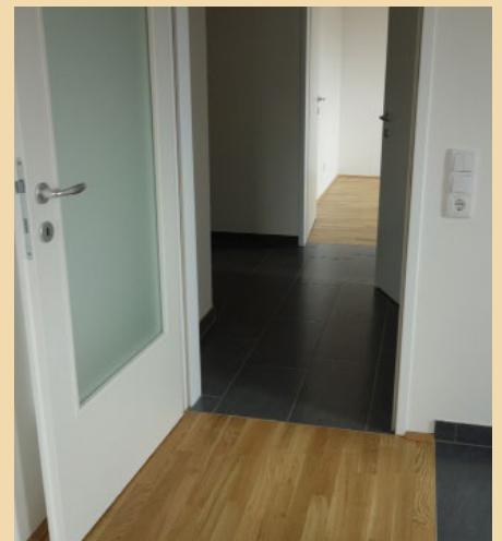
Barrierefreier Übergang der Böden, ohne Schwellen
