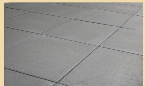
Betonplatten auf der Terrasse und im Eingangsbereich
