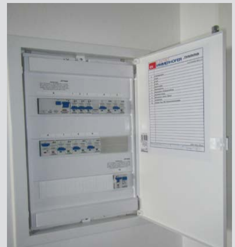
Wohnungsunterverteiler mit Sicherungsautomaten
