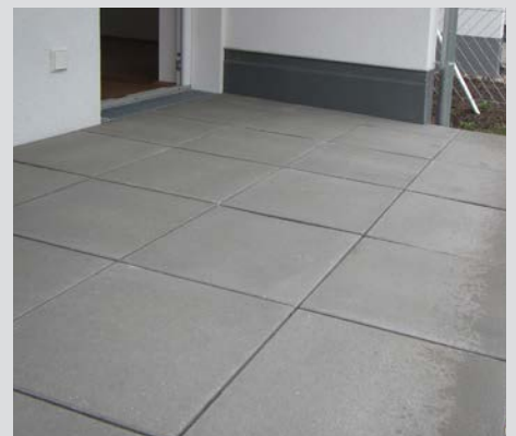
Betonplatten auf Loggia/Terrasse/Balkon
