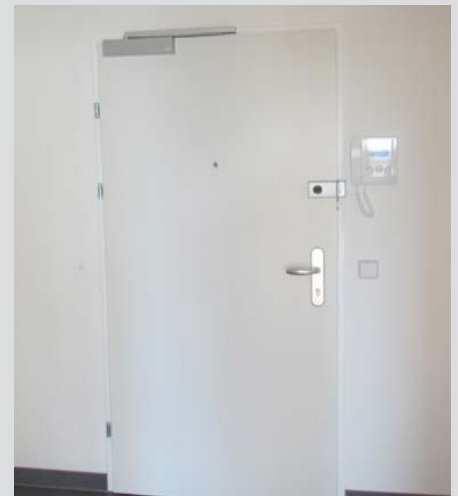
Wohnungseingangstüre inkl. Sicherheitsbeschlag, Einbauzylinder für Zentralsperre und zweites Sicherheitszylinderschloss als zusätzliche Einbruchsicherung
